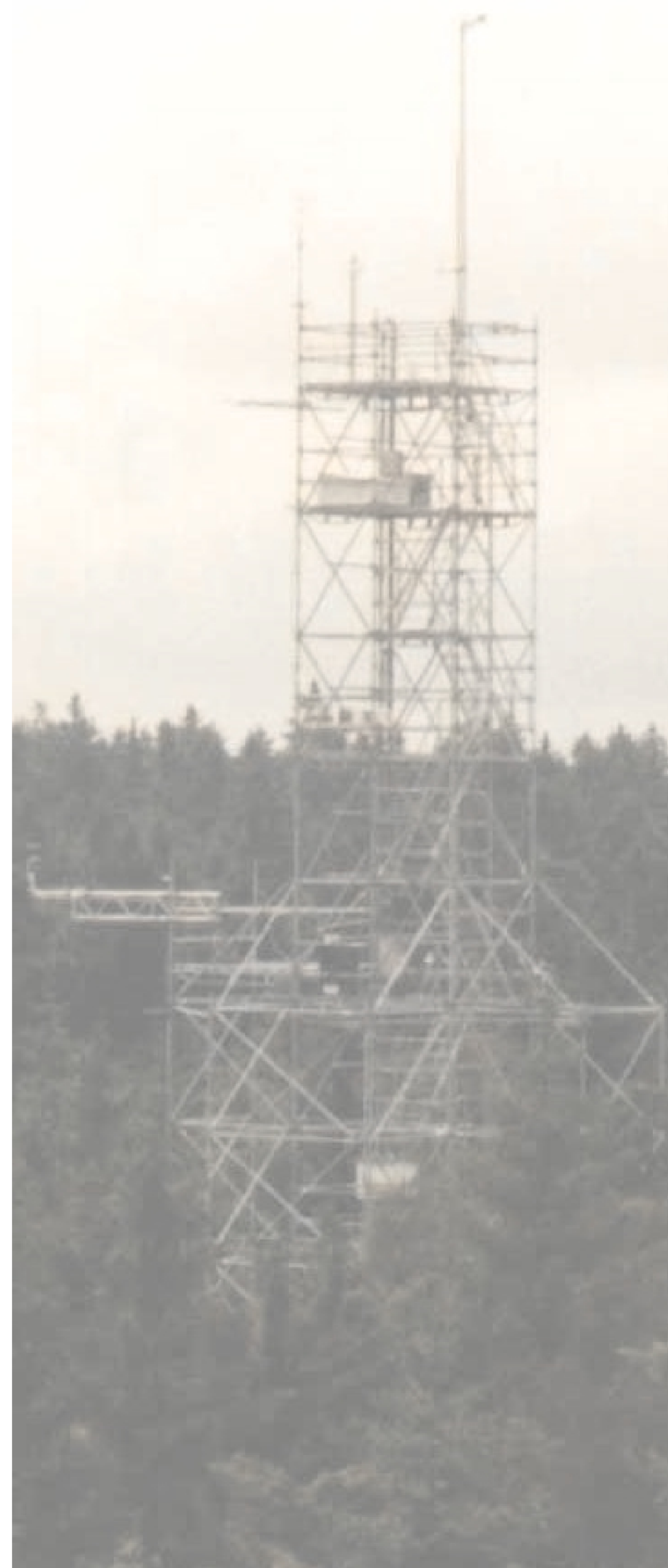
30 m-Messturm am Waldstein für mikrometeorologische Untersuchungen sowie Nebel- und Spurengasmessungen in verschiedenen Höhen
